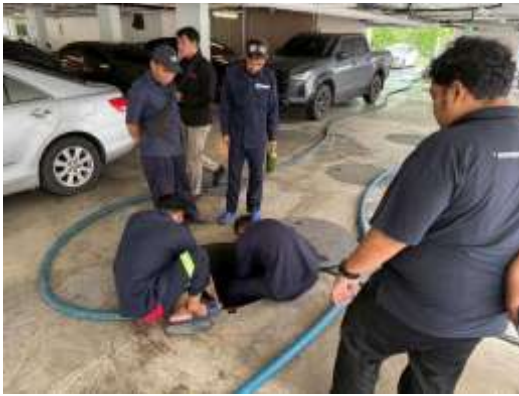
รูปที่ 41 เจ้าหน้าที่สูบล้างไขมันออกจากระบบ บำบัดน้ำเสีย
